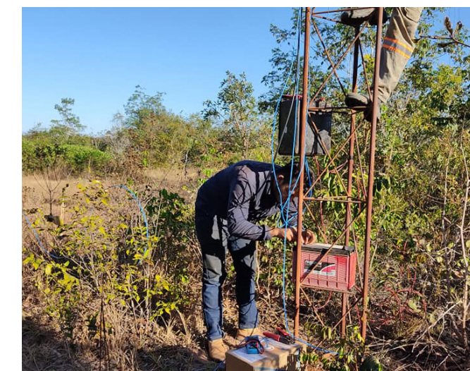
Instalação de antena de internet nas aldeias. Crédito: Redmi Note 9s, de Cleber Oloizokemae.
